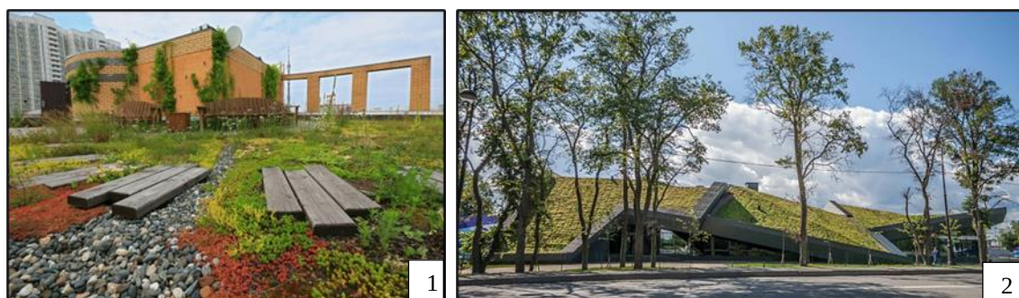
Рис. 2. «Зелёные» крыши: 1 – крыша офиса компании Илья Мочалов и Партнёры, г. Москва; 2 – клубный ресторан Royal Beach, г. Санкт-Петербург
