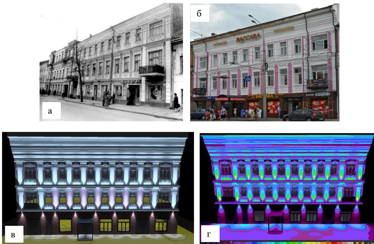
Рис. 1. «Дом Белоусова», конец XIX в., г. Ярославль, ул. Комсомольская, д. 8: внешний вид здания в 1990 г. (а) и в 2016 г. (б), визуализация освещения (в) и расчёт в фиктивных цветах (г) фасада здания в программе DIALux evo
