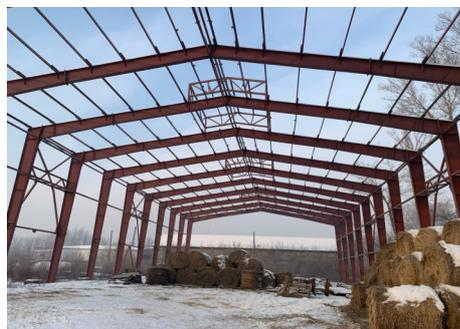
*Рис. 2. Фото конструкций каркаса здания школы верховой езды в г. Абакане*
