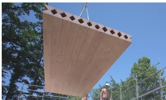
Рис. 1. Деревянная пустотная плита
