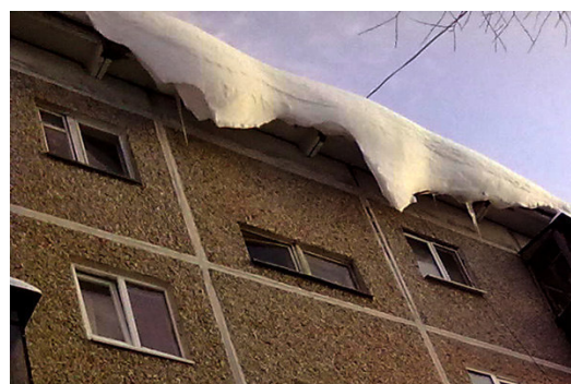
Рис. 2. Свисание снежных мешков с кровли
