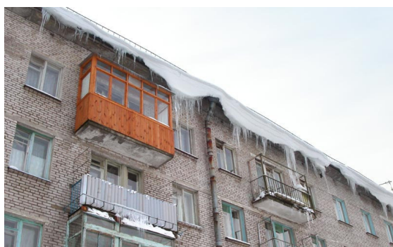
Рис. 1. Свисание снежно-ледяных масс с кровли
