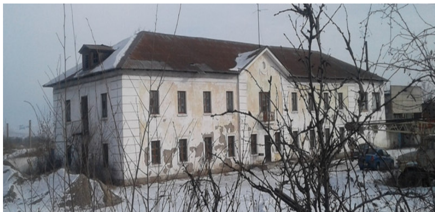
Рис. 2. Общий вид административного здания гидролизного завода в п. Усть-Абакан в настоящее время
