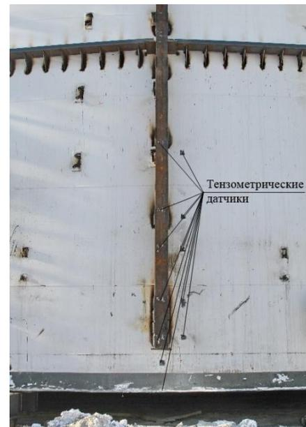
Рис. 3. РВС-20000 с приваренными вертикальными опорными рамами и кольцом жесткости на 4-м поясе стенки
